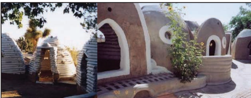
دهکده‌ی پناهگاه‌های اضطراری سازمان ملل، ساخته شده با مارپیچ‌های ابرخشت در ابعاد کوچک برای یک نفر تا یک خانواده با ویژگی ساختن سریع با دست و کمترین نیاز به مصالح و تجهیزات/ کل ارث/ کالیفرنیا
